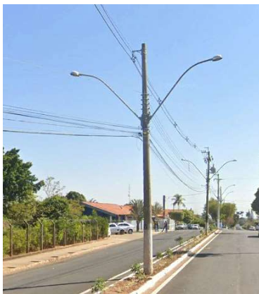
Figura 2 – Disposição desejada dos braços de iluminação
